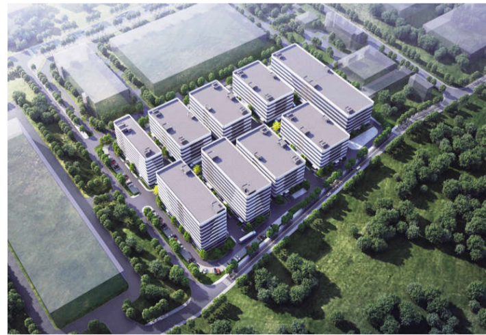
通士达海沧工业园区提升改造建设轻工视讯产业园项目(一期)
