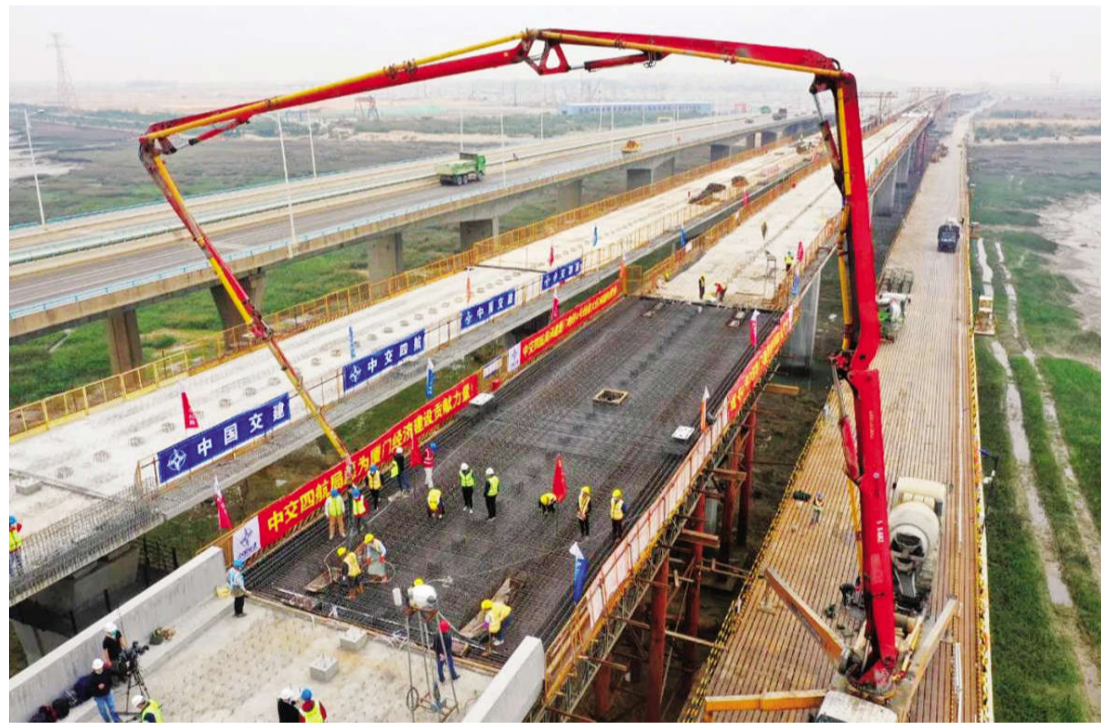
厦门地铁 4 号线跨大嶼海峡高架桥贯通
