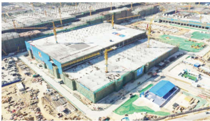
综合动力站厂房主体结构封顶。(中建一局建设发展公司提供)
