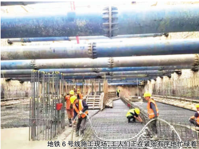
地铁 6 号线施工现场,工人们正在紧张有序地忙碌着
