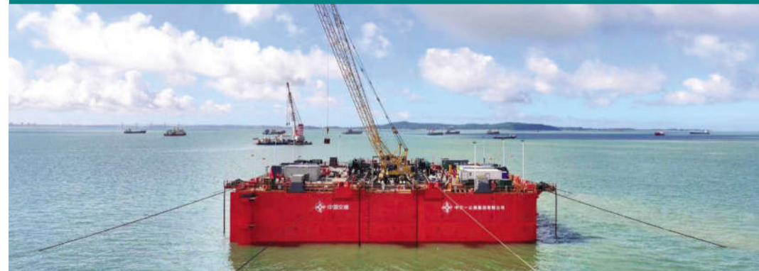
厦金大桥(厦门段)项目进展顺利。图片来源:厦门市发改委
