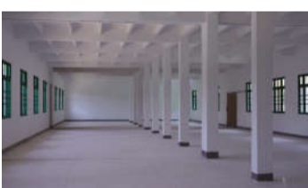
借鉴了苏式建筑风格的立柱
