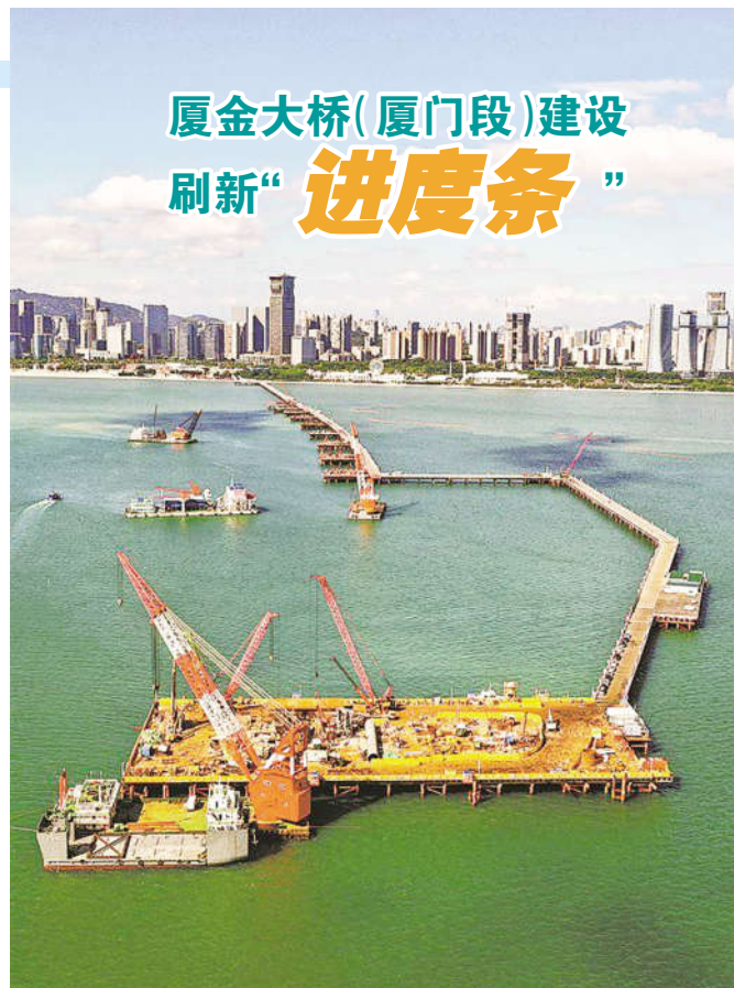
厦金大桥(厦门段)项目工程桩基施工紧张有序进行。王协云摄
